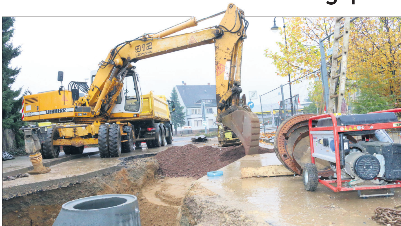
In Oschatz (Altstadtblick) werden bis zum Frühjahr 2017 die mehr als 100 Jahre alten Abwasserkanäle ausgetauscht. Foto: SPREE-PR/Arndt
