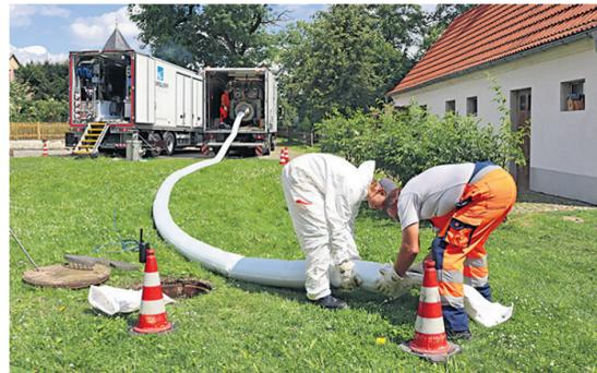
In den Kanal ziehen, aufpumpen, aushärten: Kanalsanierung im Inlinerverfahren. Foto: AV „Untere Döllnitz“
