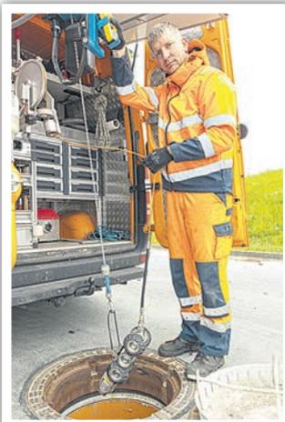
... und wird deshalb mit größter Vorsicht und Sorgfalt behandelt. Beim Herablassen in den Kanal ist das wertvolle Stück gleich doppelt gesichert.
