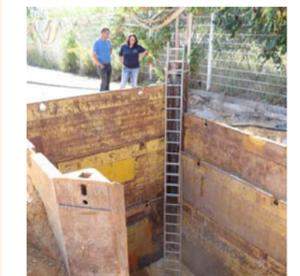
In bis zu sechs Metern Tiefe wird der Kanal auf dem ehemaligen Grundstufenwerk EKO neu verlegt.
