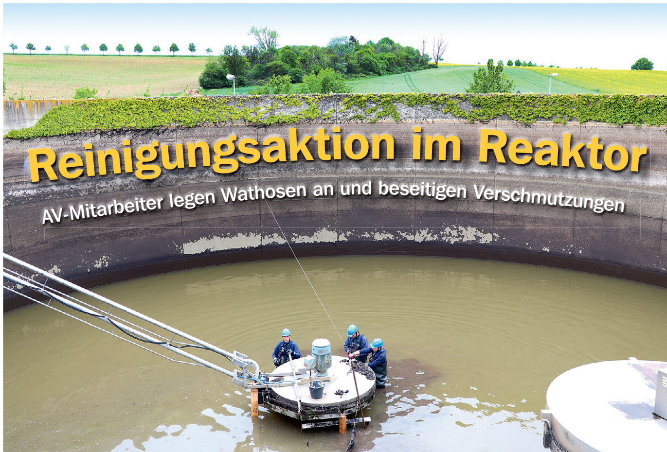
Die Reinigung der Reaktoren ist mühsam, aber für die versierten AV-Mitarbeiter schon Routine. Nach der Reinigung wurden sämtliche Teile auf Verschleiß kontrolliert und wenn nötig ausgetauscht.
