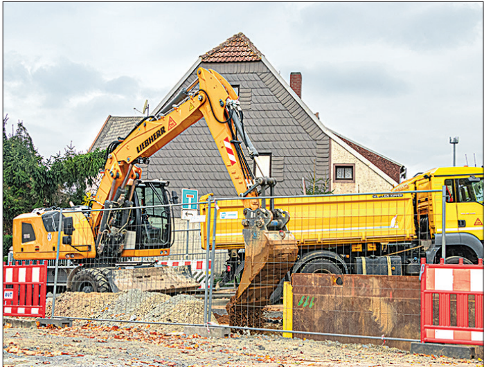
Hier wurde der Schacht in der Mühlberger Straße gesetzt und an den Mischwasserkanal angeschlossen.
