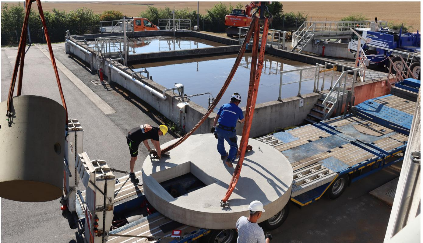
Mit geballter Kraft hielt ein Filtratwasserschacht als Zwischenspeicher auf der Kläranlage in Dahlen Einzug.
