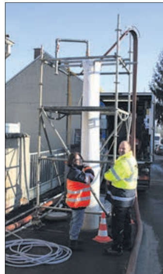
Bereits Ende 2014 wurde ein Inliner eingezogen – damals im Kanal Dreibrückenweg in Oschatz. Yvonne Häschel, Ingenieurin des Abwasserverbandes, überwachte zu jener Zeit den Bauvorgang, der in dieser Form nun in der Mühlberger Straße stattfindet.
