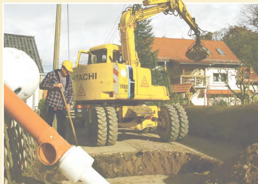
Baustelle in Hof – hier werden neue Vakuumleitungen für Schmutzwasser gelegt.
