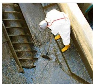
**Die Oschatzer Förderschnecke wird ausgebaut.**
