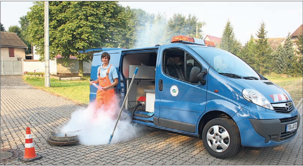
Nebulöses am Kanal – in Wellerwalde prüfte Abwassertechniker Ted Linke mithilfe des neuen Einsatzfahrzeugs, ob Fremdwasser in das Entsorgungsnetz eingeleitet wird.
