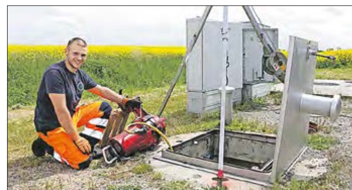
AV-Mitarbeiter Stephan Mann an der ausgebauten Pumpe in Terpitz.
