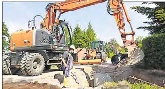
Dietmar Kayser (vorn) und Denis Palaske von der Dahlemer Bau GmbH errichten das neue Auslaufbauwerk in Lonnewitz. Foto: SPREE-PR/Arnitt
