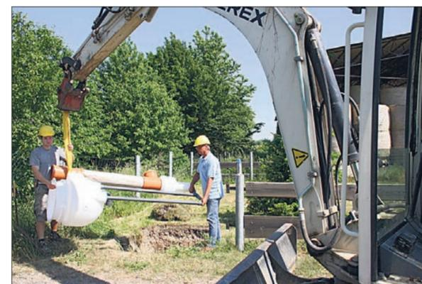
Christian Anders, Bauleiter bei der Dahlemer Bau GmbH und Lothar Nitzsche, Bauingenieur beim AV setzen einen Vakuumschacht in Merkwitz.
