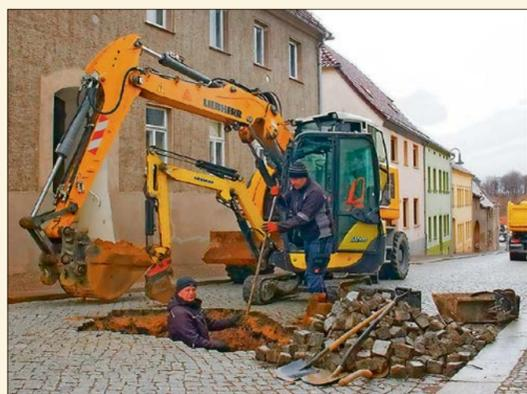
Sanierung der Mischwasserkanäle am Dahlemer Markt. Je nach Zustand wurden die vorhandenen Anschlussleitungen mittels Schlauchlining renoviert oder, bei starken Schäden, neu bis zum Hauptkanal verlegt.
