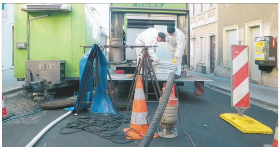
Diese Baustelle in der Oschatzer Strehlaer Straße ist seit März Vergangenheit. Um zu sichern, dass der Schmutzwasserkanal dicht ist, ließ der Verband einen neuen Kanal im bisherigen einziehen (Inliner).
