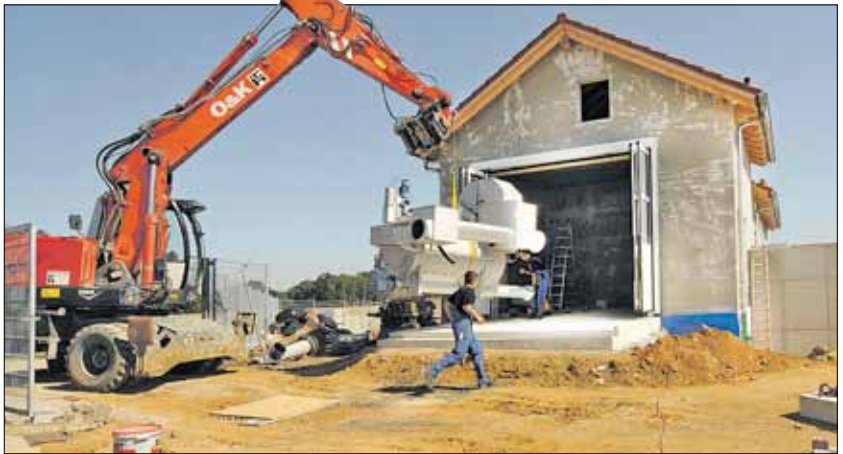
Das Herzstück der neuen Dahleiner Kläranlage wurde von Spezialisten Anfang dieses Monats in das Betriebsgebäude manövriert. Die Kompaktanlage besteht aus einem Rechen und einem Sandfang, die unter anderem Sand und Fett aus dem Abwasser entfernen.
