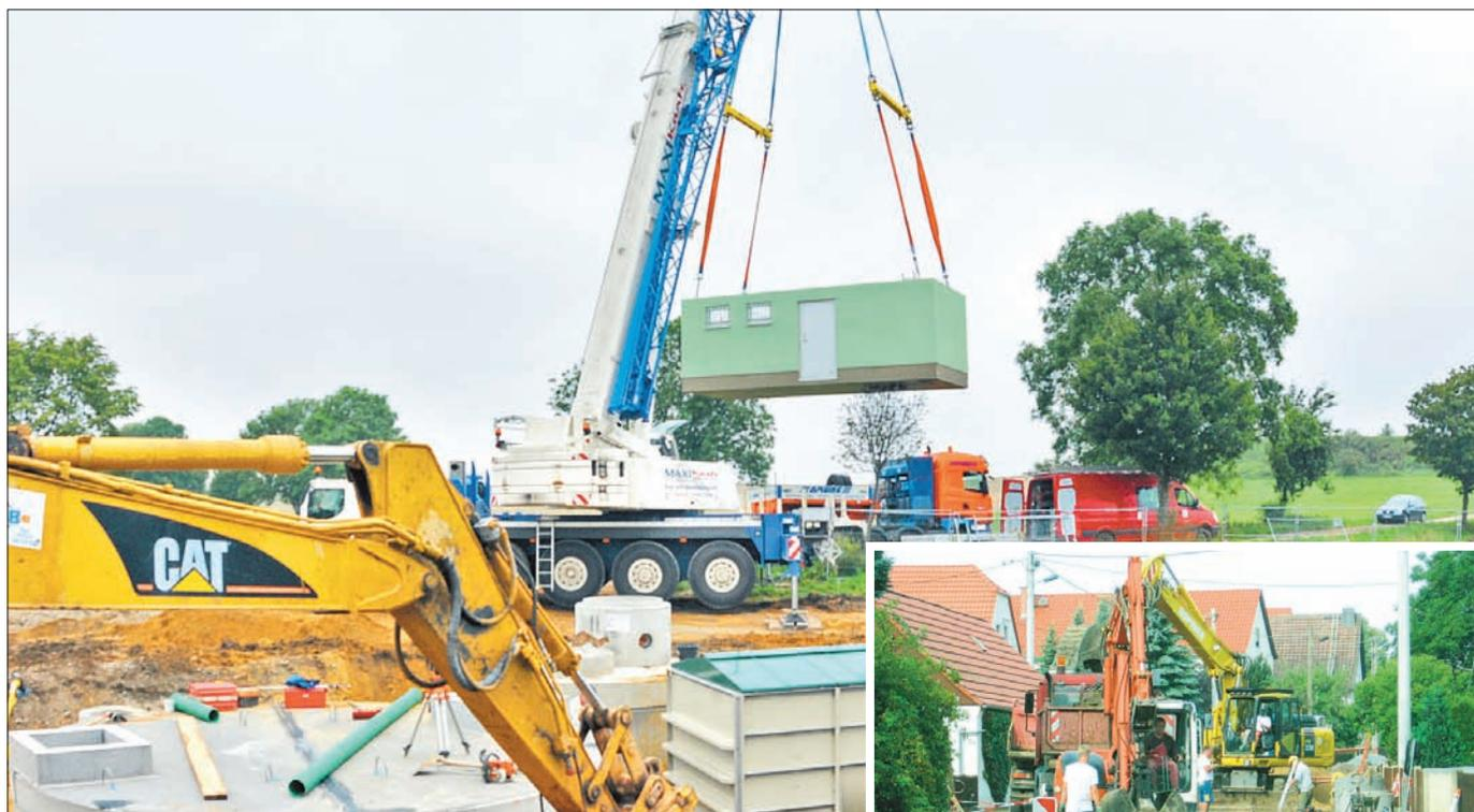
Angeschwebt: Das neue Betriebsgebäude für die Kläranlage in Laas ist Anfang August mit dem Kran angeliefert worden. In der Laaser Hauptstraße (kl. Foto) wurde von April bis September der Schmutzwasserkanal verlegt.
