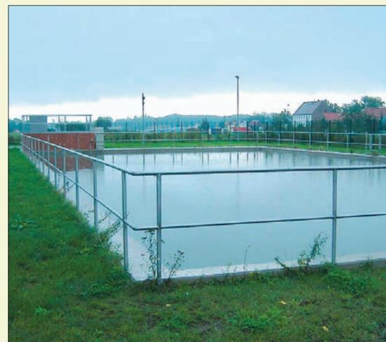
Rückhaltebecken wie dieses in Lonnewitz werden vorgeschaltet, um die Kanalisation bei Regen zu entlasten.
