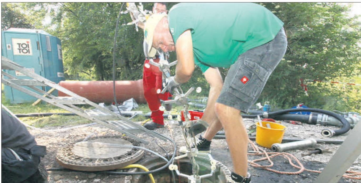
Eine Lichterkette wird in den Kanal eingelassen, um den Inliner auszuhärten. So entsteht mittels grabenlosen Reparaturverfahren ein neues Rohr im Rohr – ebenso korrosions- wie verschleißfest.
