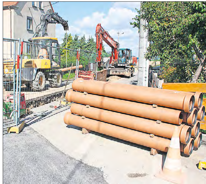
Schweres Gerät wird benötigt, wenn Stadt und Abwasserverband gemeinsam Straßen und Kanäle erneuern.
