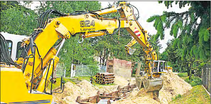
Schweres Gerät bei der Arbeit am Abwassernetz. Foto: SPREE-PR/Archiv
