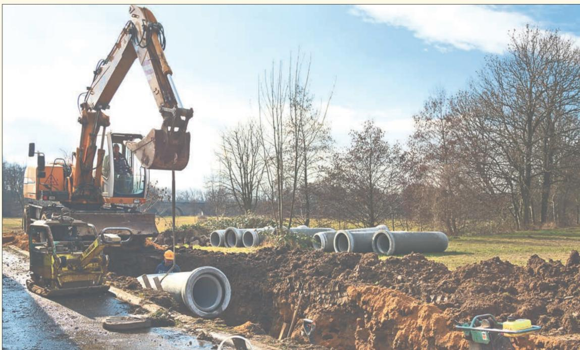
Eine von vielen Baustellen des AV „Untere Döllnitz“: Bauarbeiter verlegen neue Abwasserrohre in direkter Nachbarschaft zur Döllnitz.
